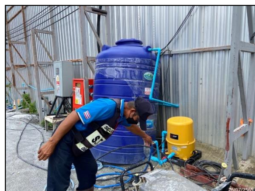
ภาพที่ 26 ตรวจสอบการรั่วซึมของเส้นท่อประปา
