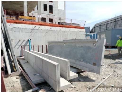
ภาพที่ 14 ใช้เทคนิคก่อสร้างแบบสำเร็จรูป
